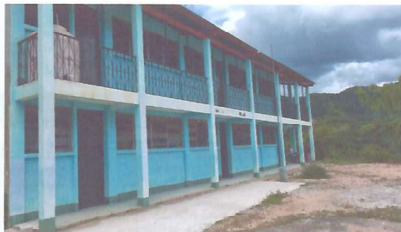
Foto 2: MEJORAMIENTO DE PINTURA DE FACHADA Y DOS AULAS
