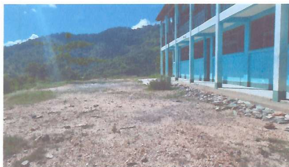
Foto 3: MEJORAMIENTO DE LOSA DE PATIO
